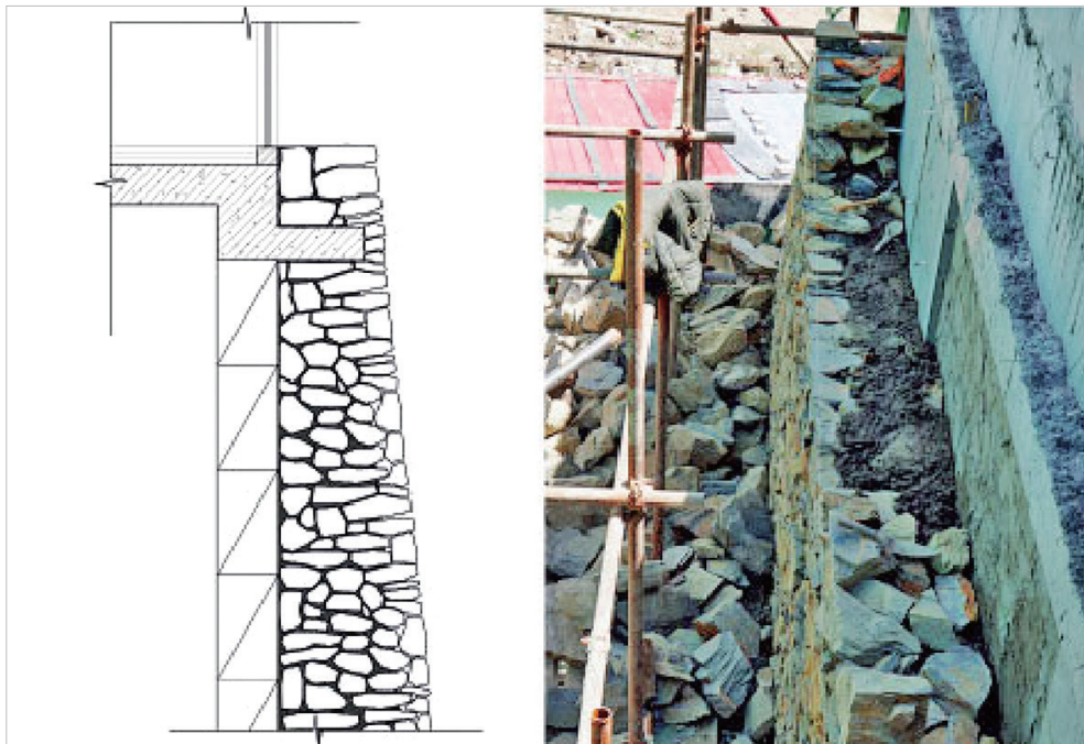
图10 复合墙体与灰缝处理 [9]
